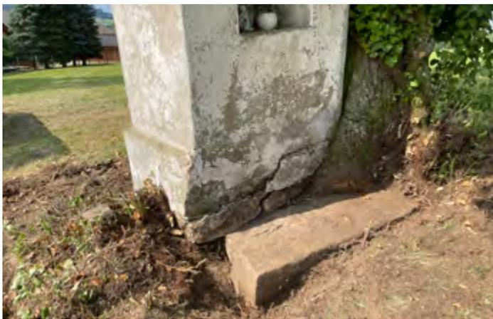
Deutlich sieht man, wie die Linde den Bildstock bedrängt und mit Stamm und Wurzelwerk bereits Schäden am Mauerwerk verursacht. Es wurde auch ein riesiger Stein, der als Vorplatz diente freigelegt.
