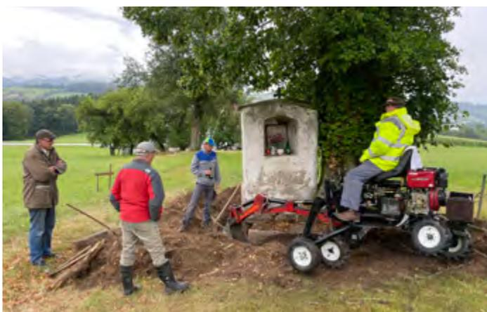
Ziemlich schweißtreibend war die Entfernung von Bewuchs und die Freilegung des Fundaments – wo wir mit Krampen und Schaufel nicht mehr weiterkonnten, unterstützte uns Konrad Enne mit seinem Bagger. Nach der Sicherung des Bauwerks mit Kanthölzern, Gurten und Technik der Firma Schalungsverleih Ing. Bernhard Stiefsohn kam die kritische Phase: Wird es gelingen, das Fundament des Bildstocks mit Eisentraversen zu unterfangen, ohne das Bauwerk nachhaltig zu beschädigen?
