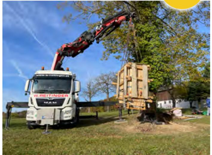
Der Bildstock hoch in den Lüften – groß war die Freude, als das Bauwerk problemlos vom Kran der Firma Reitinger (vermittelt von Alois Enne) aus seiner Verankerung gehoben wurde und punktgenau von Kranführer Wiltcheck auf das zuvor betonierte Fundament gesetzt wurde.
